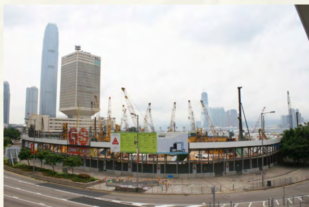
添馬艦地盤的地基工程正在施工。
