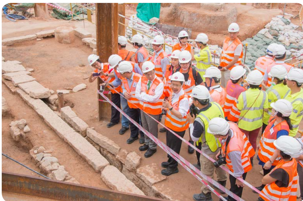
交通事務委員會委員在沙田至中環線土瓜灣站的建築工地進行視察。
