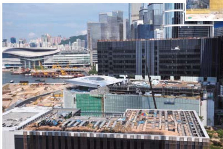
施工中的立法會綜合大樓建築工程。
